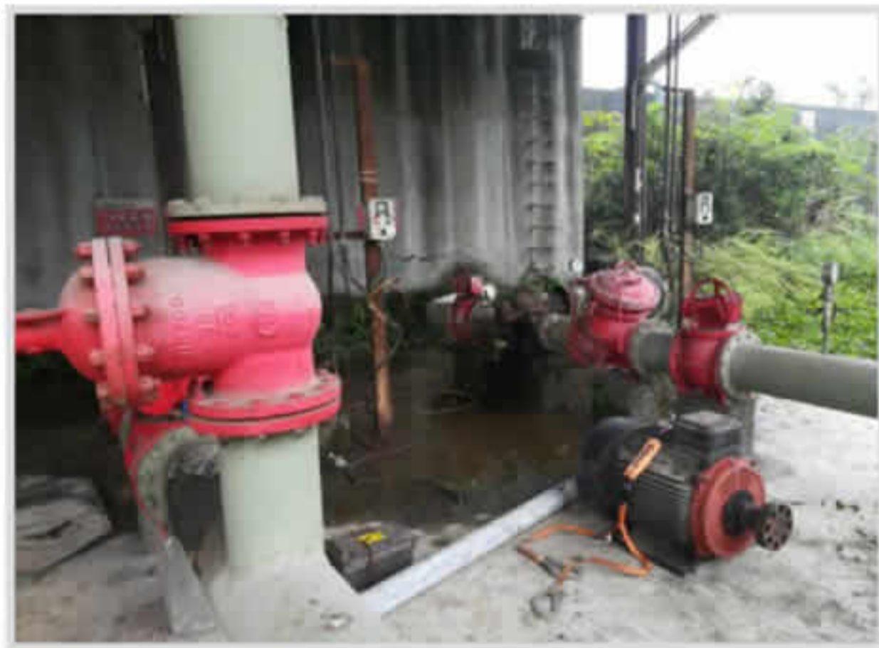
1号消防泵拆除
