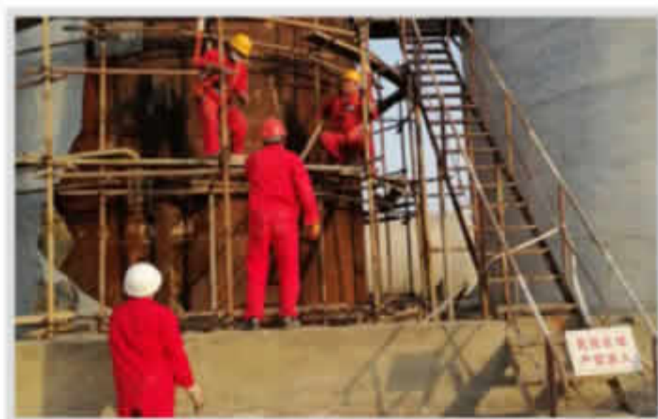
罐体拆除搭建钢管架
