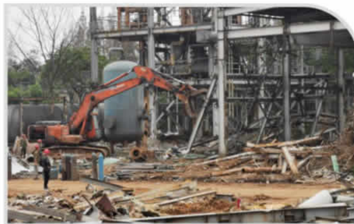
500吨干法塔拆除作业
