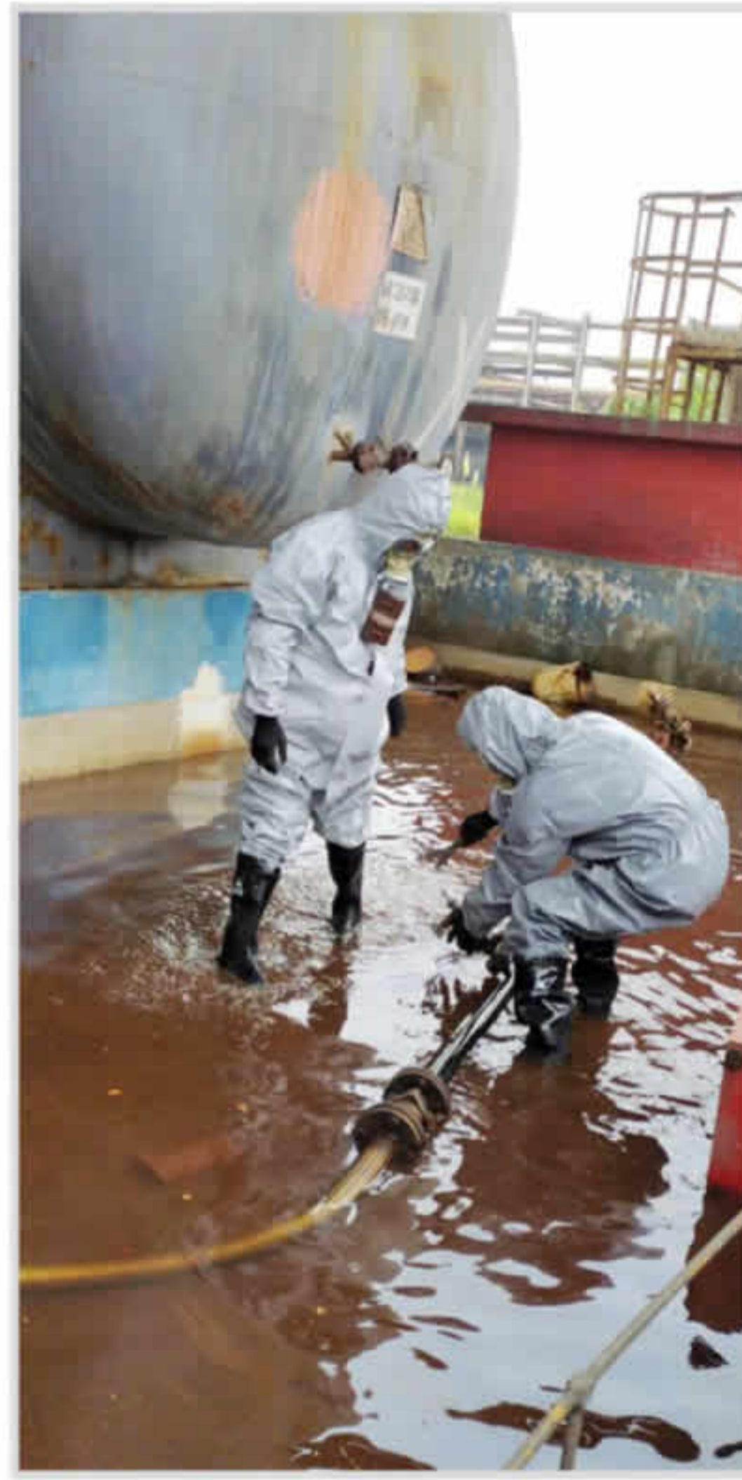
罐区氯硅烷取样
