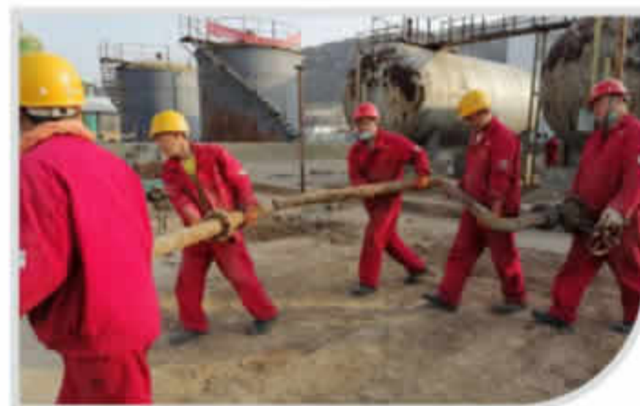
地下管线拆除作业
