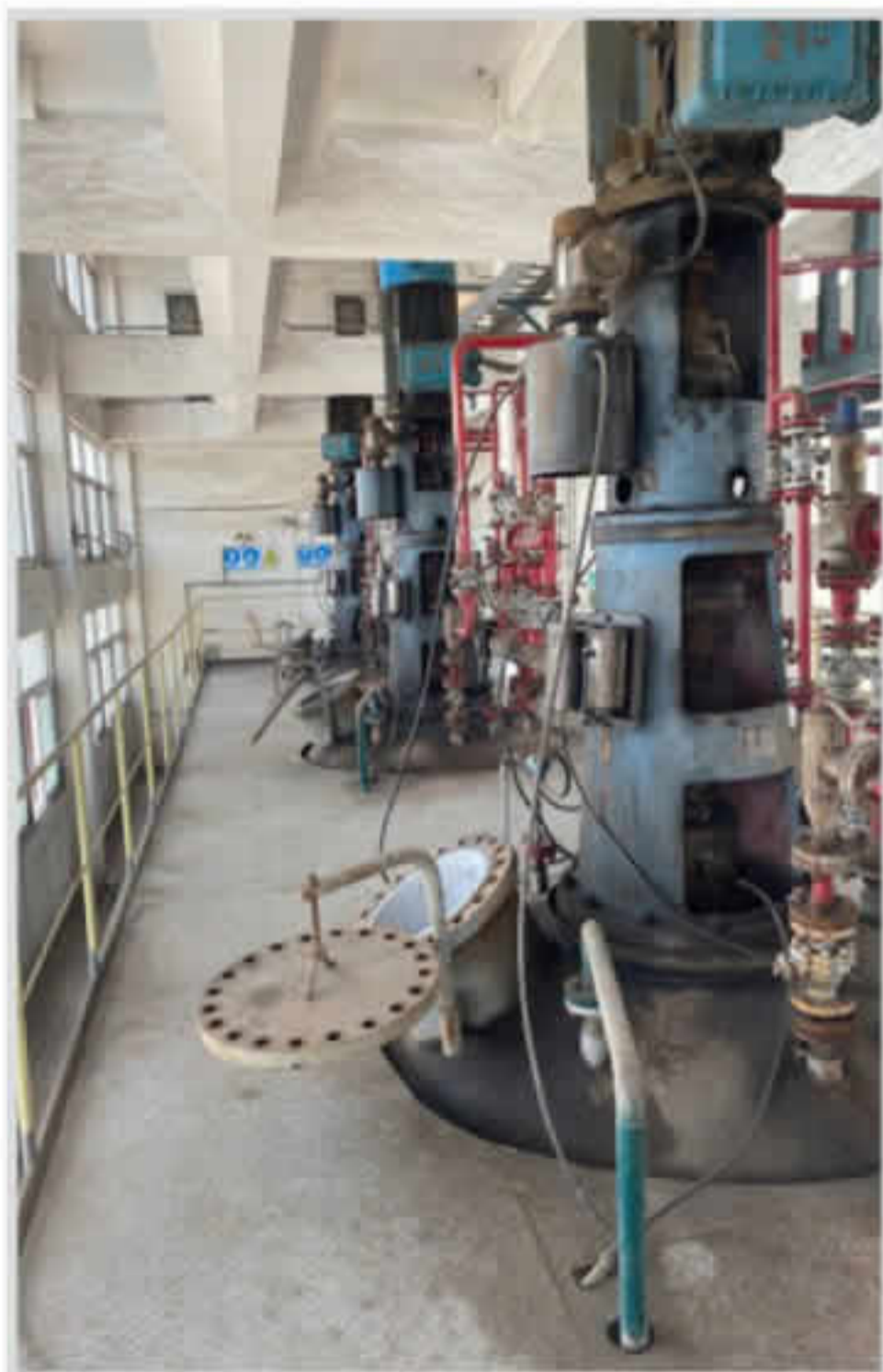
脱硫塔人孔拆除
