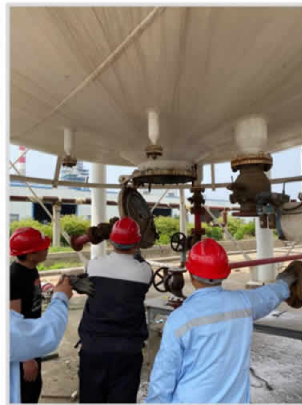
丙烯球罐人孔检修
