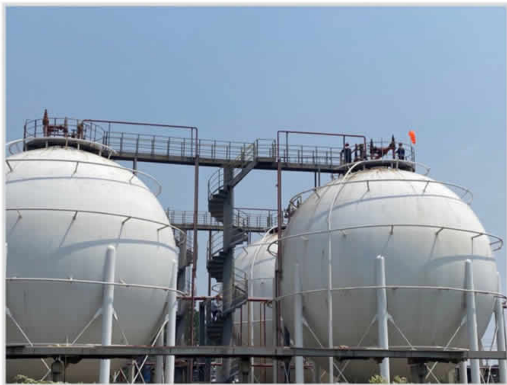
丙烯球罐置换
