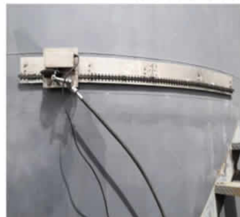
高压水切割拆除设备
