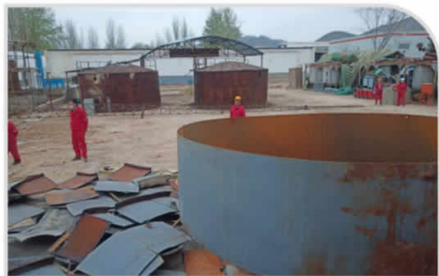
水切割后罐体分解
