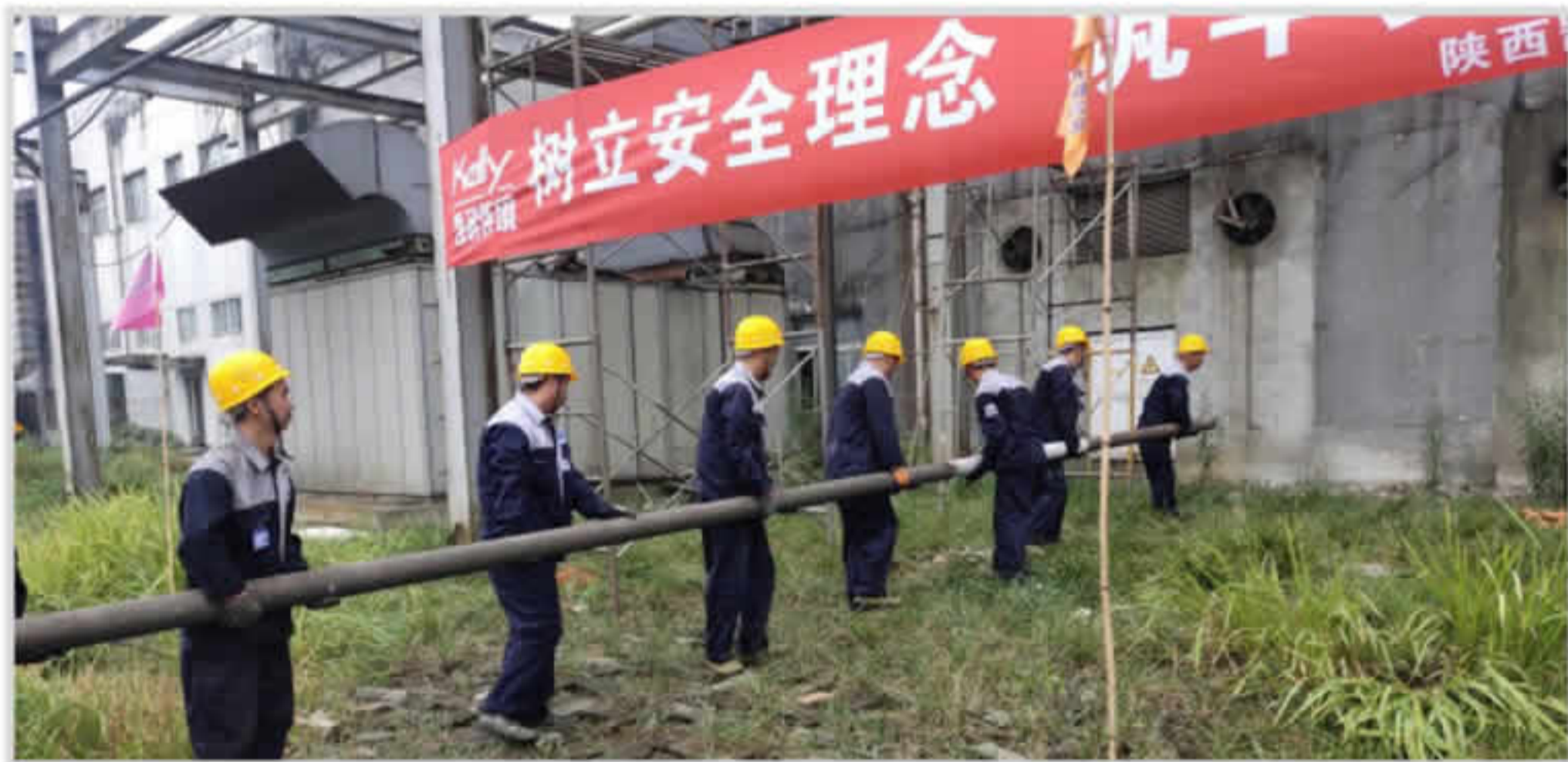
氮气进出管道焊接
