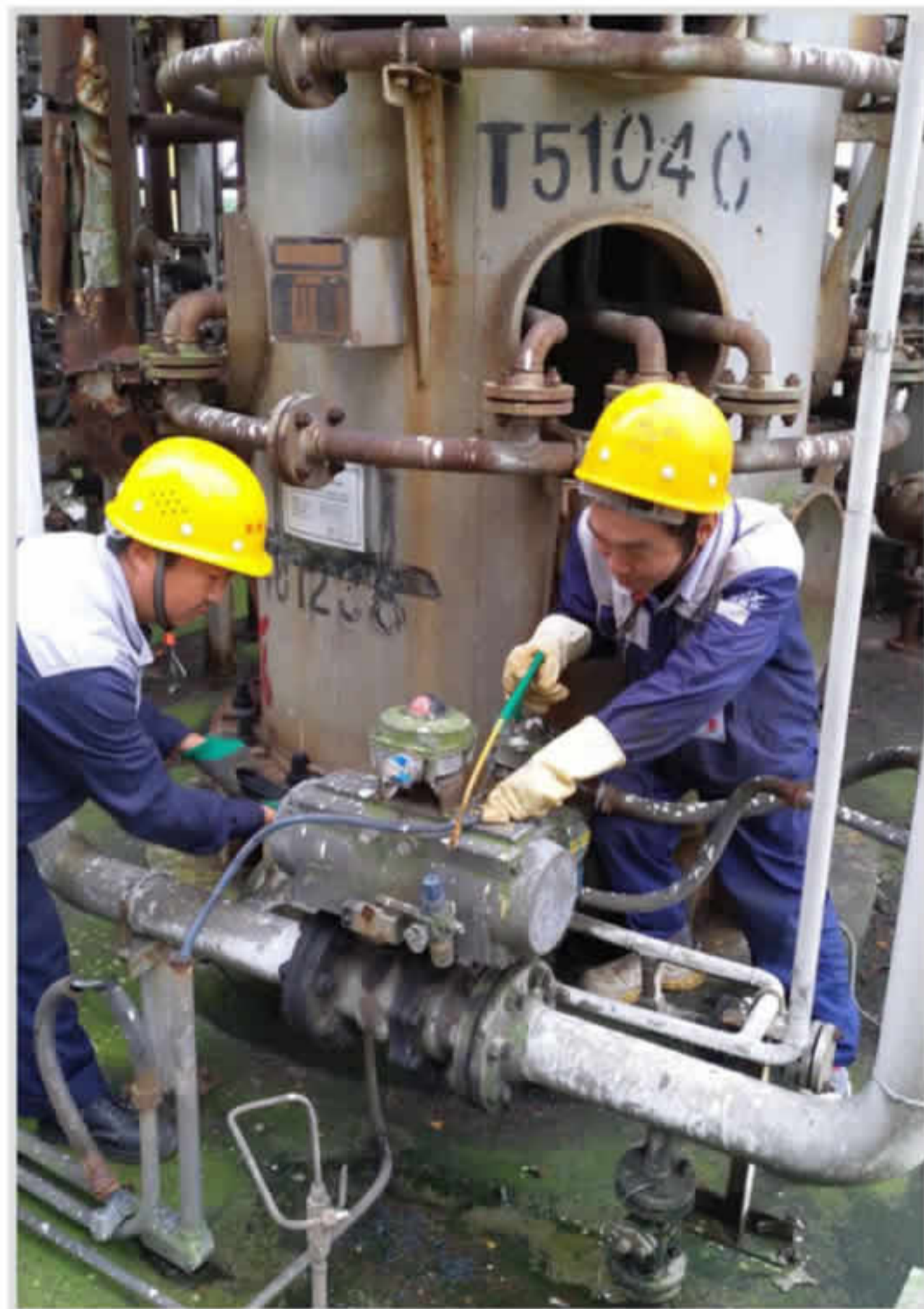
拆除VGR系统气动阀门
