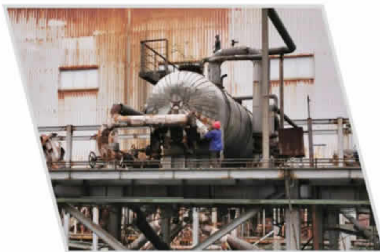
500吨还原水冷却系统冷却罐拆除作业
