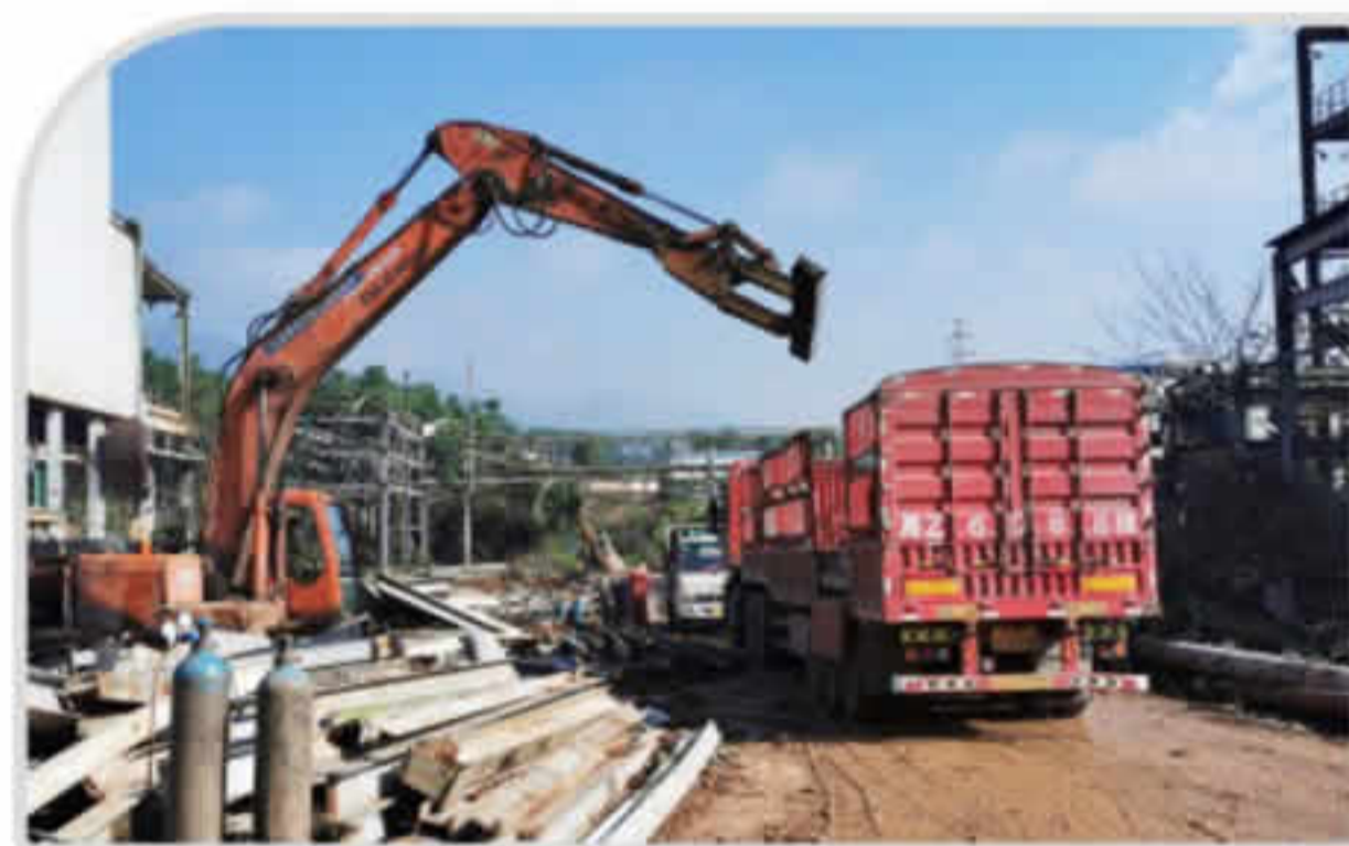
500吨多晶实验楼拆除作业
