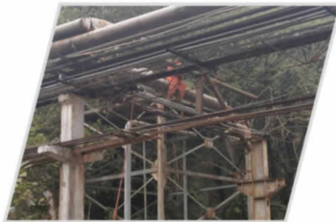
500吨还原水冷却系统冷却罐拆除作业
