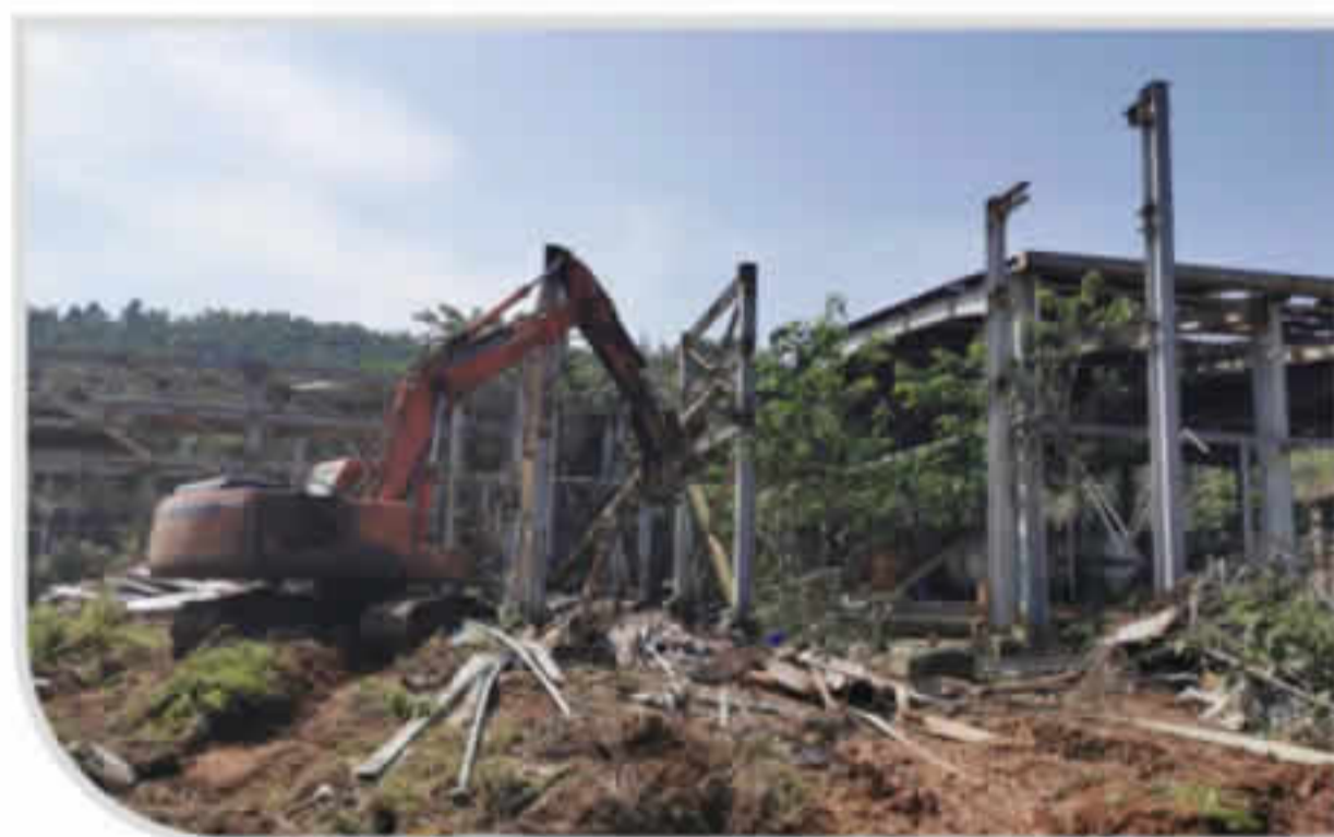
500吨罐区拆除作业
