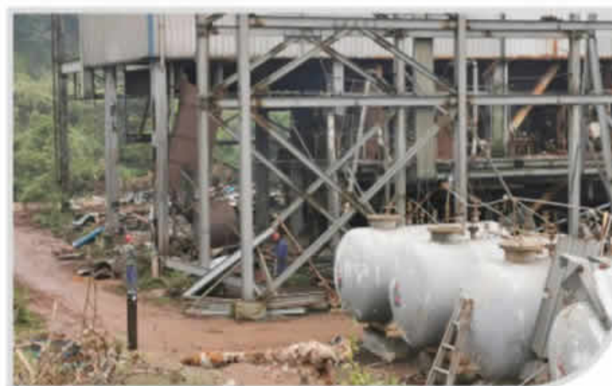
500吨还原低沸物罐拆除作业
